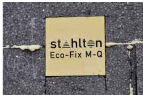
Kostka po wbudowaniu musi licować się z warstwą ocieplenia.
